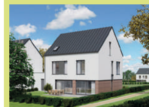
WELFRANGE surface totale 245 m 2 1.675.200 €
